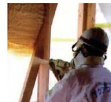
通常ガスを使用して充填させることが多い断熱材。アクアフォームは硬質ウレタンフォームの特性を生かし水を使って発泡させます。これにより柱と柱の間、細かい部分にも隙間なく充填することができます。オゾン層破壊や地球温暖化の原因となるフロンを全く使用しない、地球にやさしいウレタンフォーム素材です。グラスウールの1.5倍以上の断熱効果を保持し、透湿性も低く断熱材内部に湿気を侵入させないため、壁体内の結露を防止し、建物の耐久性を高めます。
