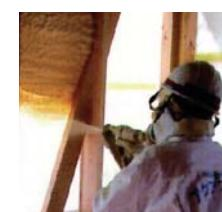
通常ガスを使用して充填させることが多い断熱材。アクアフォームは硬質ウレタンフォームの特性を生かし水を使って発泡させます。これにより柱と柱の間や、細かい部分にも隙間なく充填することができます。オゾン層破壊や地球温暖化の原因となるフロンを全く使用しない、地球にやさしいウレタンフォーム素材です。グラスウールの1.5倍以上の断熱効果を保持し、透湿性も低く断熱材内部に湿気を侵入させないため、壁体内の結露を防止し、建物の耐久性を高めます。
