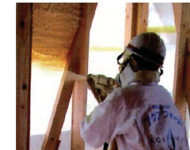
通常ガスを使用して充填させることが多い断熱材。アクアフォームは硬質ウレタンフォームの特性を生かし水を使って発泡させます。これにより柱と柱の間や、細かい部分にも隙間なく充填することができます。オゾン層破壊や地球温暖化の原因となるフロンを全く使用しない、地球にやさしいウレタンフォーム素材です。グラスウールの1.5倍以上の断熱効果を保持し、透湿性も低く断熱材内部に湿気を侵入させないため、壁体内の結露を防止し、建物の耐久性を高めます。
