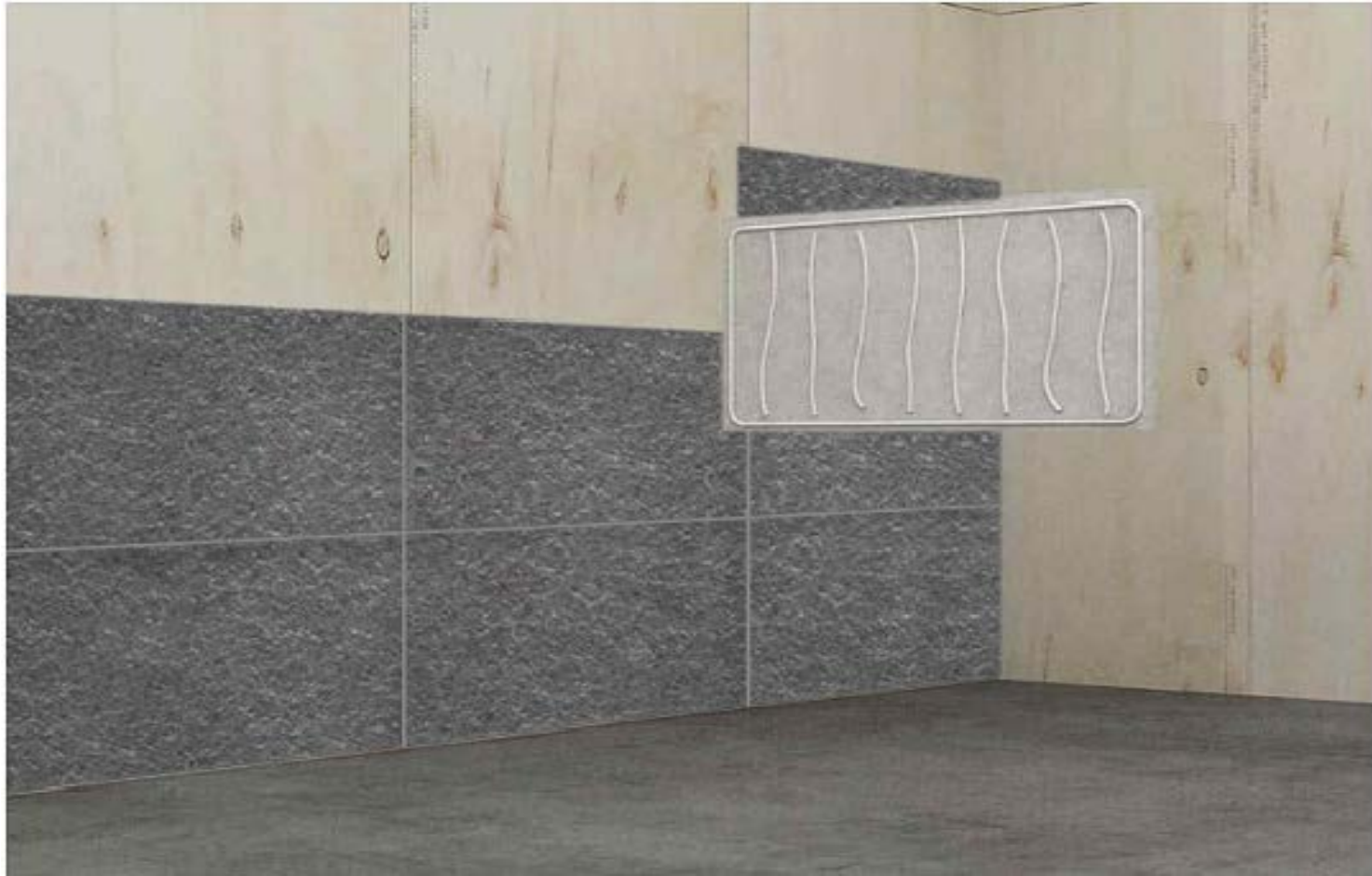
② レコストーン裏面に専用ボンド塗り付け作業
