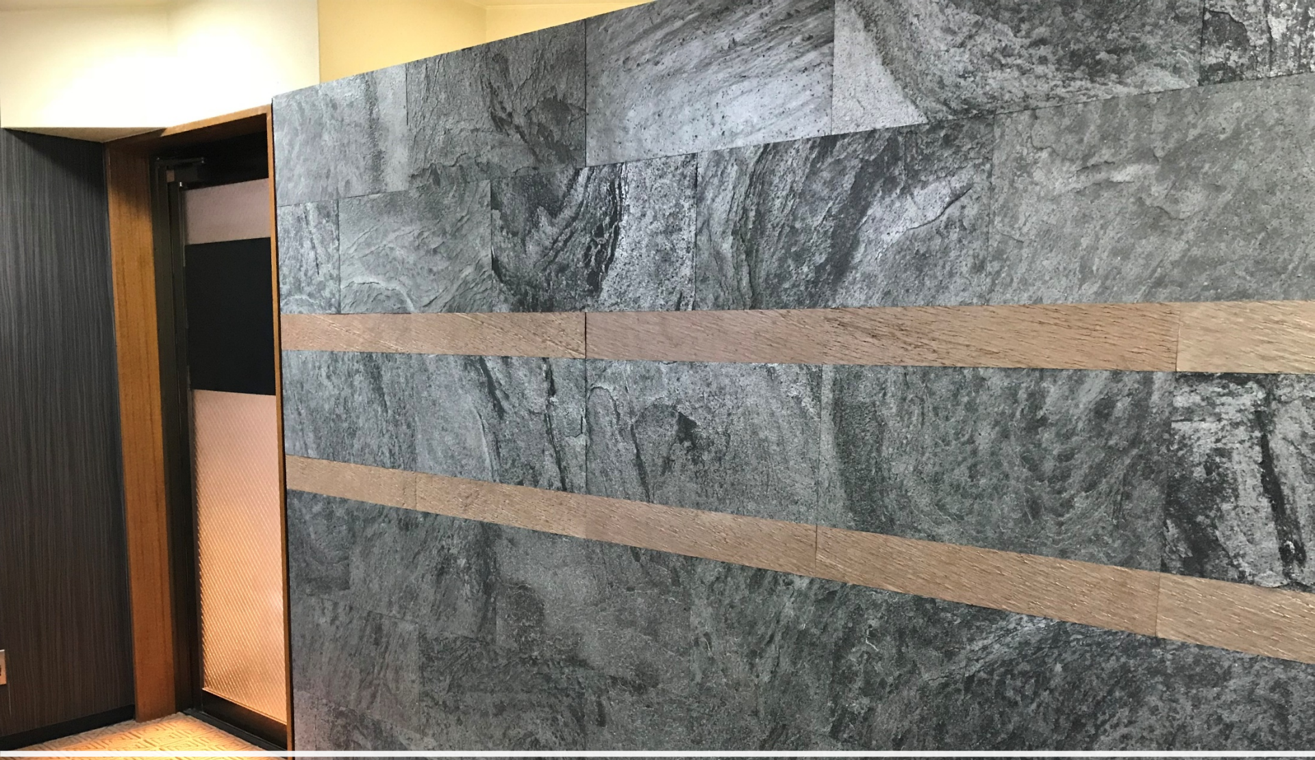
施工事例（石陶 摂津営業所）
